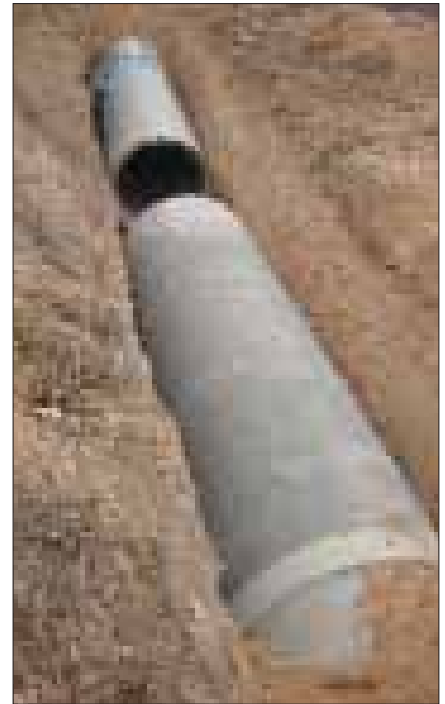
Arriba, unión mediante junta elástica. A la izquierda y abajo, colocación de tubería y relleno posterior con retroexcavadora.
