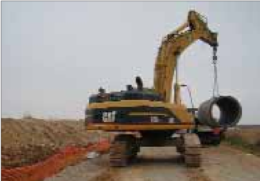
Arriba, unión mediante junta elástica. A la izquierda y abajo, colocación de tubería y relleno posterior con retroexcavadora.
