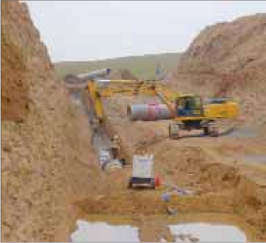
A la izquierda, tubería de hormigón con camisa de chapa. Arriba, colocación de las tuberías. A la derecha, fachada del ayuntamiento de Soses (Lérida). Y abajo, balsa de almacenamiento del proyecto de mejora hidráulica que permita el riego mediante redes de presión.
