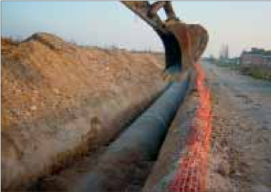
Rellenado con material granular y el esquema del relleno.
