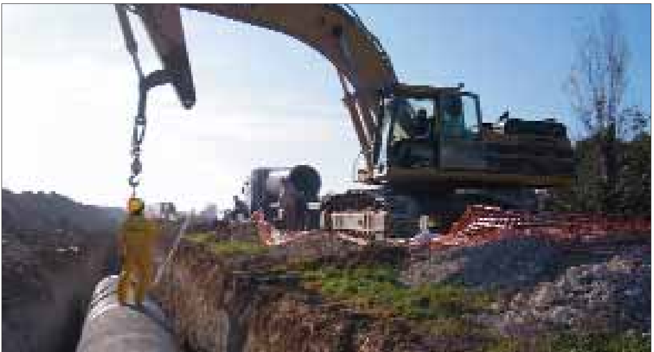
Arriba, unión mediante junta elástica. A la izquierda y abajo, colocación de tubería y relleno posterior con retroexcavadora.
